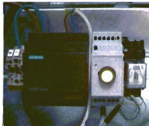
Bild 4 Externer Notaus- Taster „S ENA“ im Schaltschrank C2
